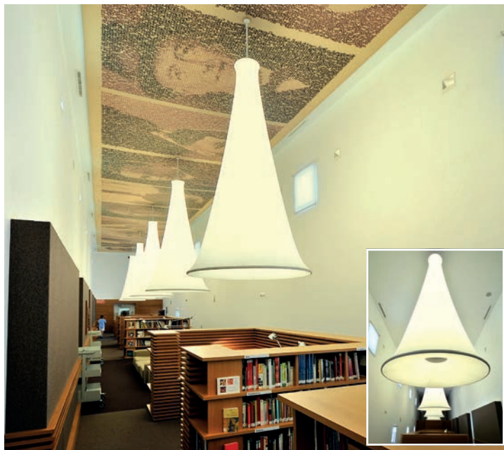
luminaires Barrisol® - réalisation : INGENYO
